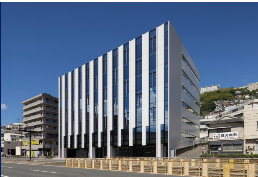
長崎駅前電気ビル
